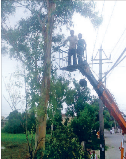
सोनीपत। पेड़ों की कटाई करवाते बिजली कर्मियों, बिजली लाइन जहां पर मरम्मत कार्य किया गया, पेयजल सप्लाई की मरम्मत कार्य के लिये खोदे गड्ढे में भरा पानी।
